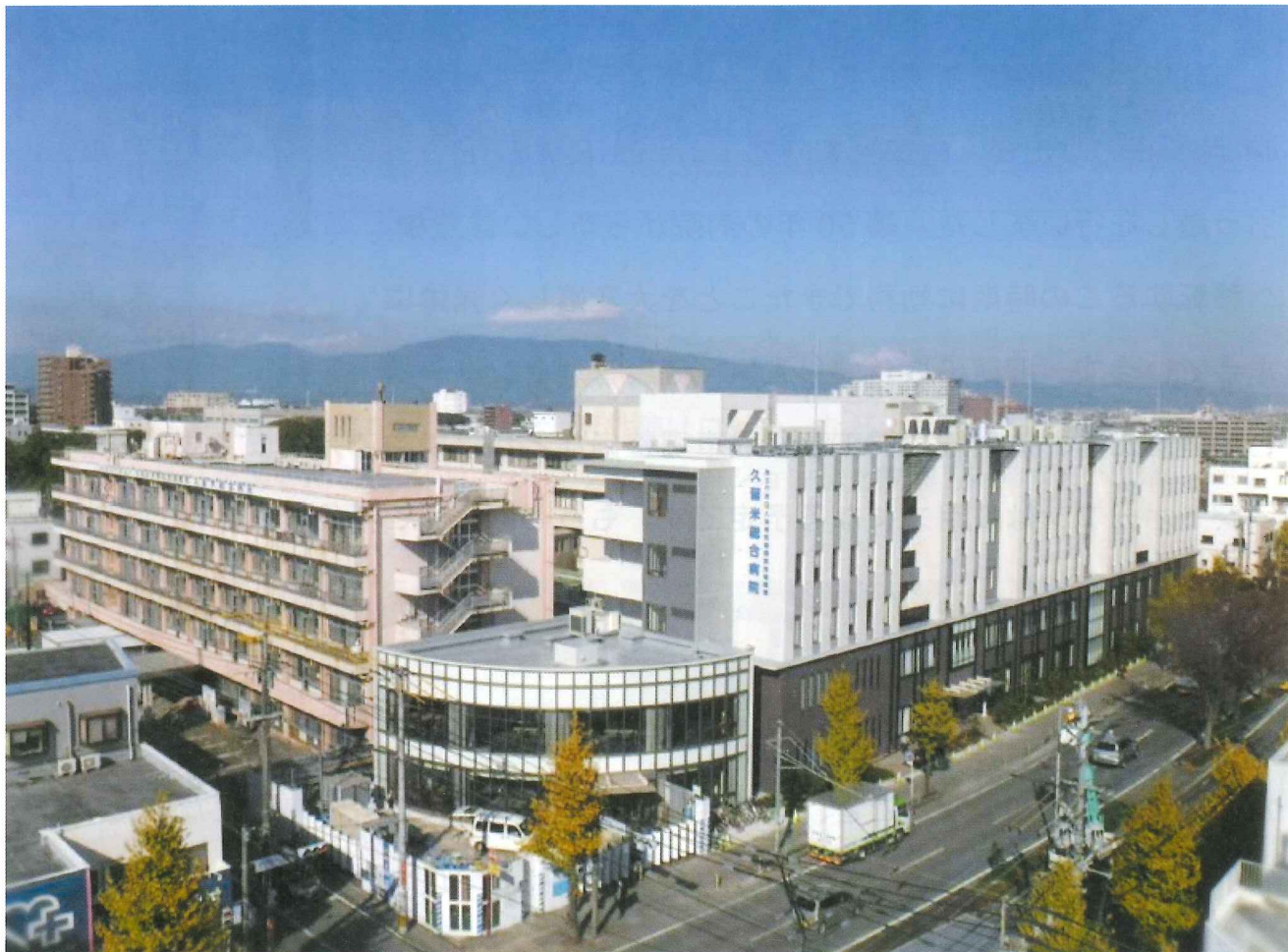
2015年12月撮影「新診療棟建設状況」より
